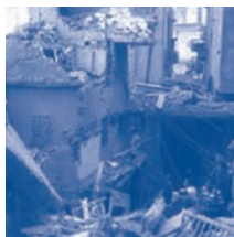
Imágenes del terremoto de Cachemira
